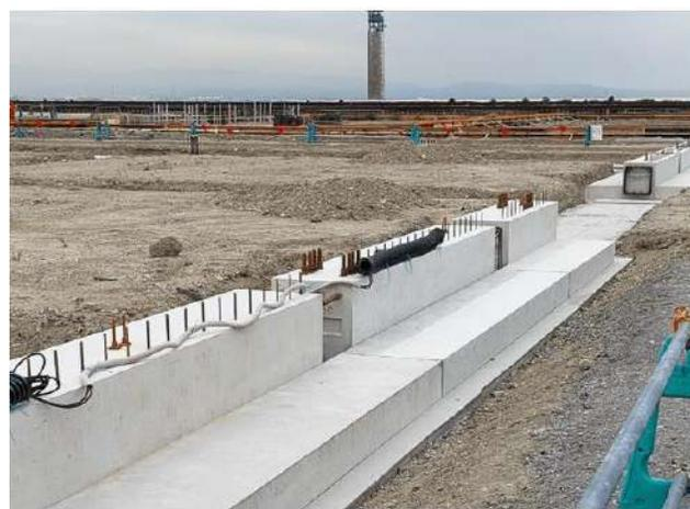
CNコンクリートの製造実験・実適用
